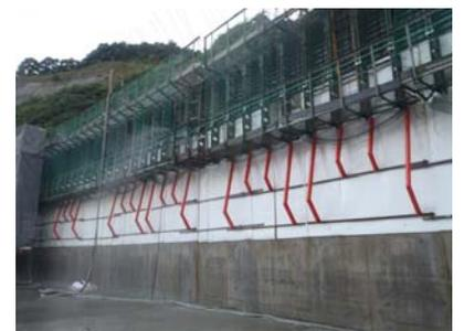
写真-1 断熱湿潤養生状況(導流壁)
