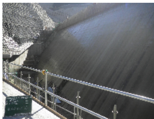
写真-1 堤体下流面における流水養生状況
