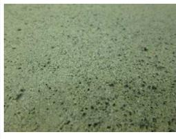
表面がザラザラしており、細骨材が露出している。            |
