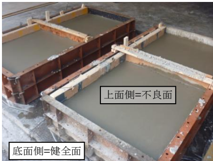
写真-1 コンクリート打ち込み状況
