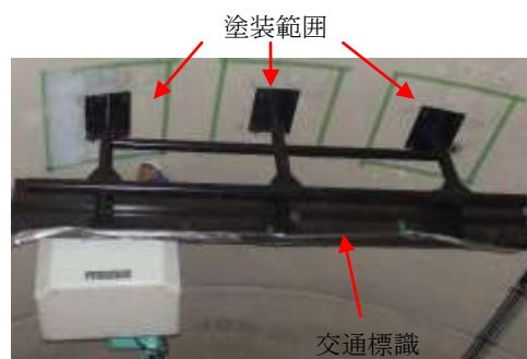
Fig.5 塗装工事
