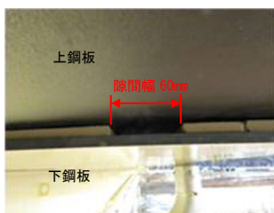
図-6 施工対象箇所
