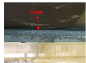
図-8 施工完了後
