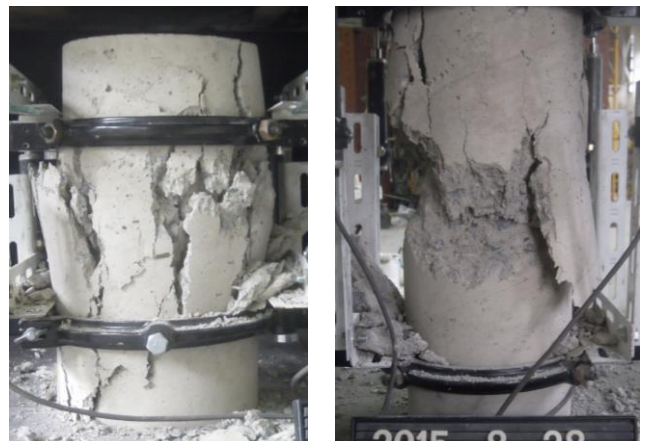
図8 最終破壊状況（左：300-0-N，右：450-0-N）
