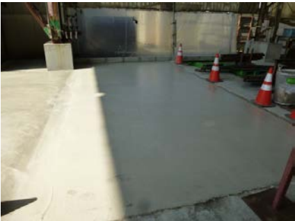
b) 養生完了後
