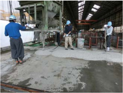
a) バケットによる打込み
