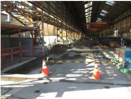
図1 施工前の状況
