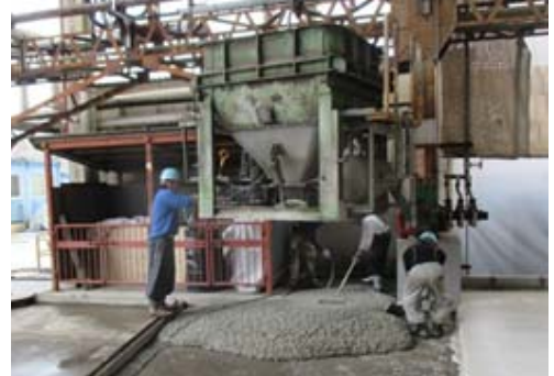
写真-1 バケットによる打込み状況
