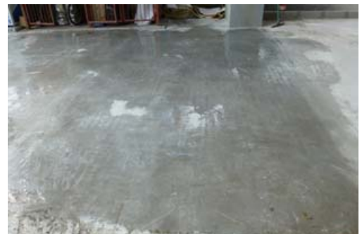
写真-2 養生完了後の仕上げ状況
