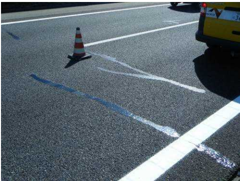
写真-1 アスファルトシール工による水の浸透防止
