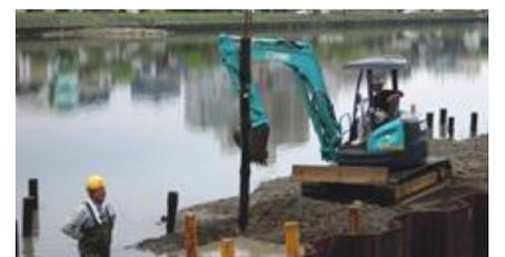
写真-1 杭出し水制工の回収状況
