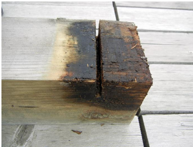
写真-2 床版部材端部裏面
