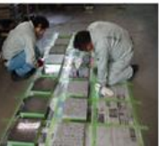
プライマー塗布
