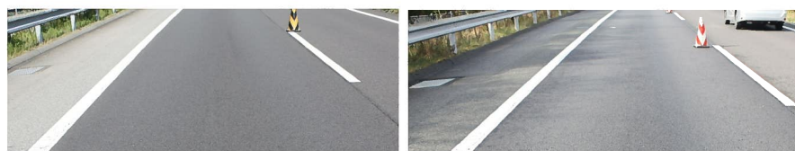
写真-1 骨材飛散の少ない現場の路面状況 (左：散布前，右：散布後 7 ヶ月)
