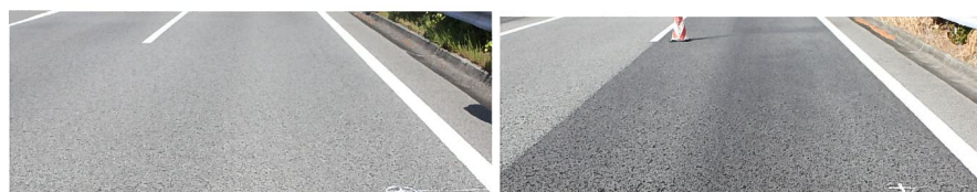
写真-2 骨材飛散の多い現場の路面状況 (左：散布前，右：散布後 7 ヶ月)
