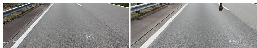
写真-3 他の試験施工現場の路面状況 (左：散布前，右：散布後 6 ヶ月)
