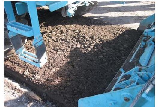
写真-2 路上破砕混合機による混合状況
