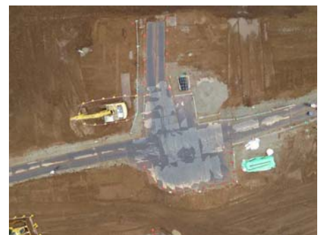
写真 - 4 空撮状況
