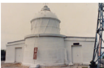
写真 1 明治期灯台 5 の外観 4)
