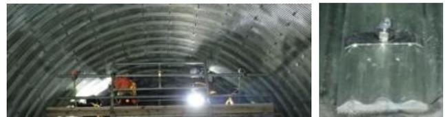
図-5 施工状況(左)と座金および緩衝材(右図)
