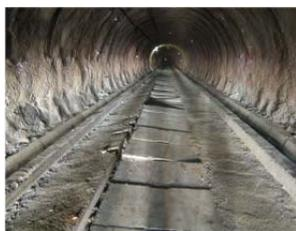
図3 顕在化した路盤変状
