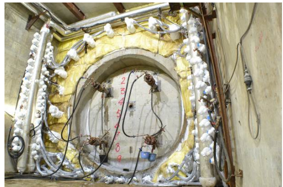
写真1 凍土造成状況
