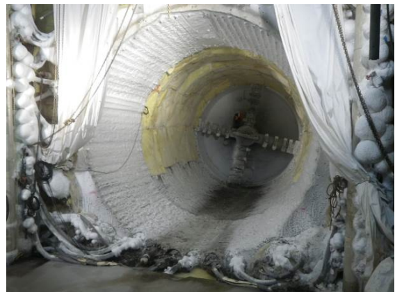
写真2 凍土掘削完了
