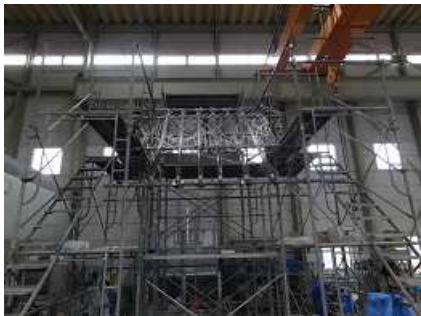
写真-1 模擬ボアホール設置状況 (設置角度上向き 45°)
