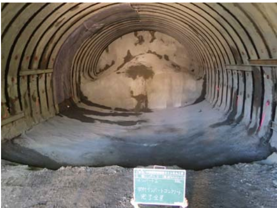
写真-2 吹付けインバート(早期閉合)施工状況
