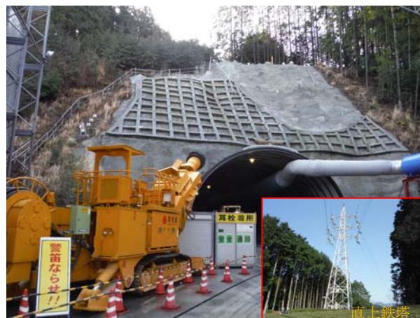
写真-3 トンネル坑口全景(終点側)
