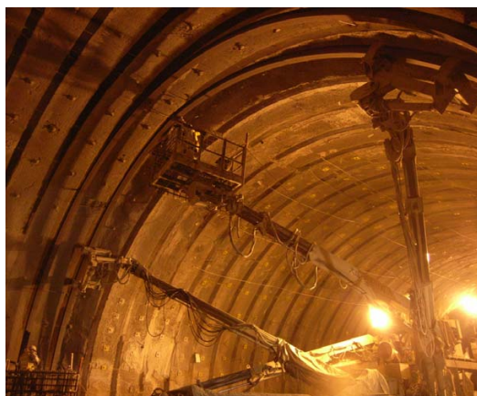
写真-2 二重支保工施工状況
