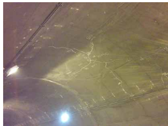
写真2 覆工コンクリートの状況
