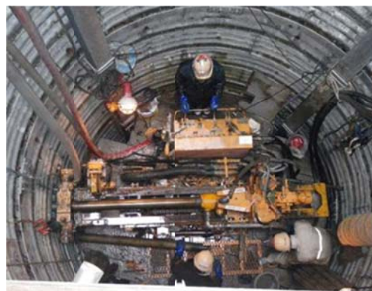
写真 1. 集水井内からの水平パイプ打設状況
