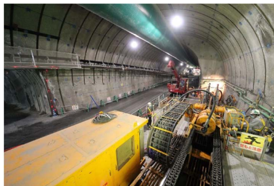
写真-1 超長尺先進ボーリング 穿孔状況
