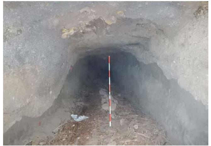
写真1 弱線部(変形帯)における崩落(A-50m付近)
