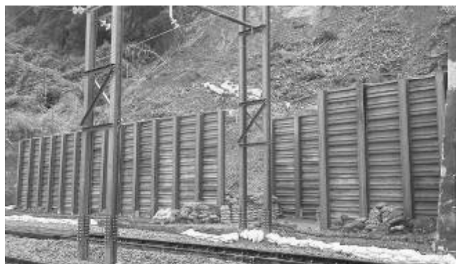
写真-2 仮土留柵設置状況
