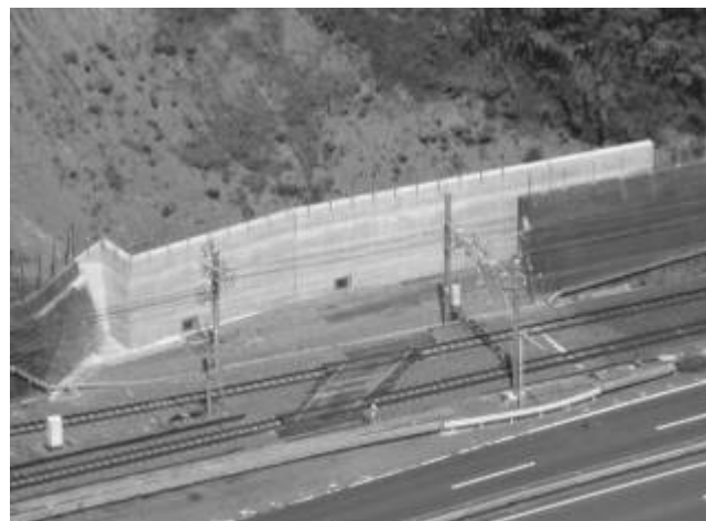
図-3 土留擁壁復旧状況
