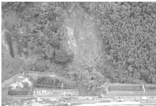
写真-1 斜面崩壊状況
