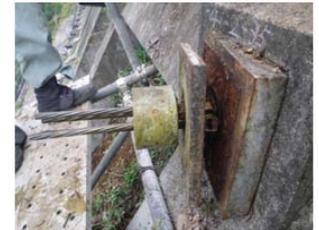
と土塊中のアンカー軸の向きの違いや土塊中に拘束部が生じた場合に、アンカーに残存緊張力以上の荷重が加わったことで、より線が支圧板等と高緊張力で接することにより発生するせん断破壊(写真-6)や、より線の腐食により引張強度の低下した部材に高緊張力を載荷されたことが主な原因と推定される。また、より線の「引抜け(引抜け傾向)」は、定着部の「より線とグラウト」、「アンカー一体と定着地盤」の付着切れが推定される(写真-7)。これらの損傷は、想定されたアンカー力が作用した場合に、のり面の安定性に直接的に影響する事象であることから、原因推定には別途追加調査を実施し必要な対策を検討実施する必要がある。
