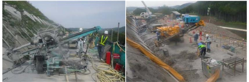
写真-2 削孔状況（左：足場設置 右：土足場）
