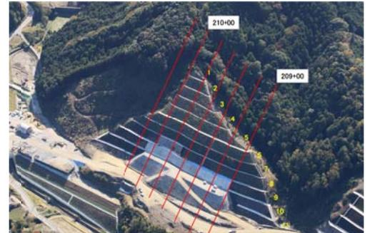
写真-1 法面の全景(押さえ盛土完了時点)
