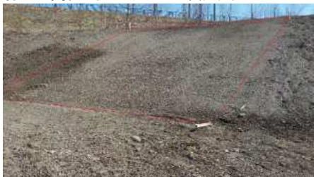
写真3 雪解け直後の法面
