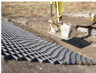
写真1 土砂充填
