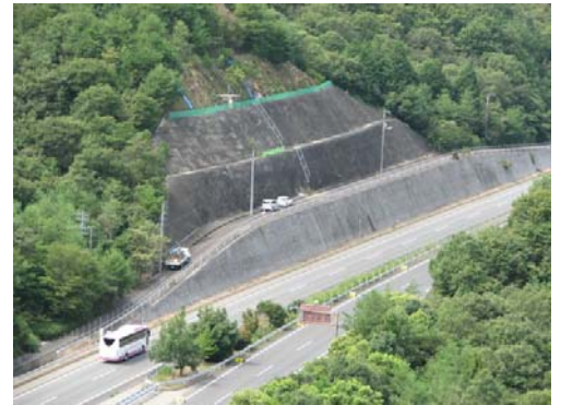
図 1 切土のり面全景
