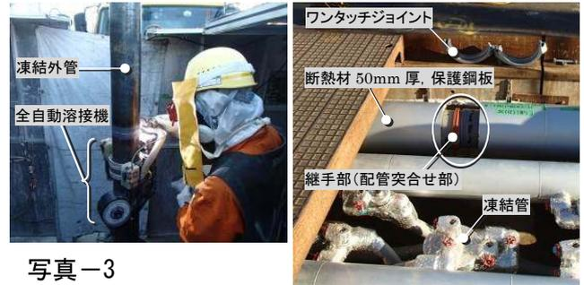
写真-3 凍結管の自動溶接
