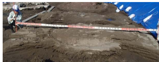
写真-1 試験施工における多扇形改良体
