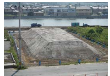
写真-4 盛土完成状況
