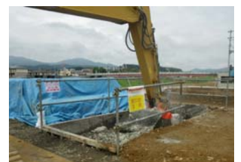
写真-3 ボンファイバー混合状況
