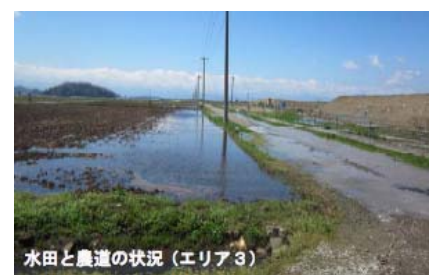
写真-1 周辺水田の沈下状況
