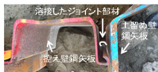
写真-1 控え壁と土留め壁嵌合部
