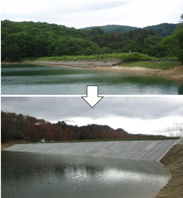
写真1 堤沢ダムの改修前・後の堤体上流側の状況
