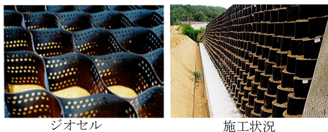
写真1 ジオセル擁壁
