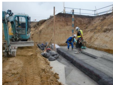
写真-1 補強材の敷設
