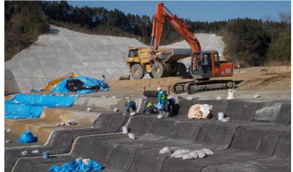
写真1 ベントナイトシート(段切型)の施工状況
