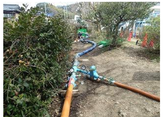
図-3 充填箇所：スタティックミキサー
