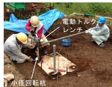
写真2 杭施工状況
