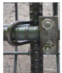
写真-4 B 工法
