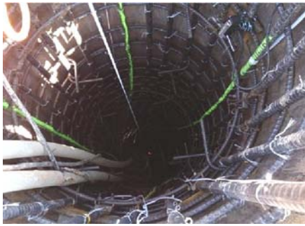
写真-6 ケーシング孔内の状況
