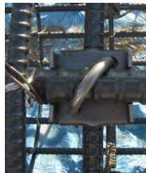
写真-2 A 工法
