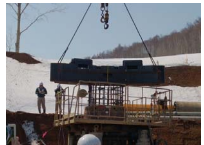
写真-5 載荷試験の状況
