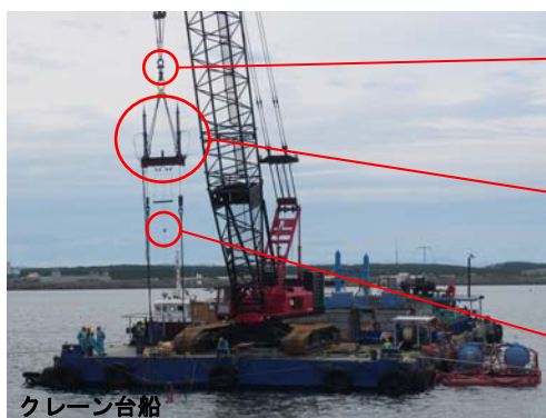
Photo 1 引抜き実験時の全景
