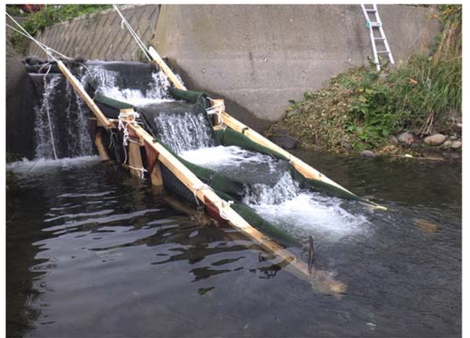
写真－3 余別新川魚道の設置状況
