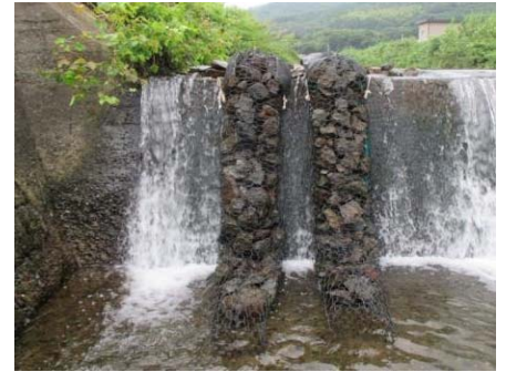
写真-2 落差工への石倉カゴの設置
