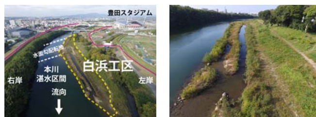
写真-1.2 矢作川・白浜工区全景、下流より施工区状況(2015 秋)
