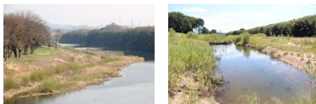
写真-3.4 上流より施工区現況(2016 春)、ワンドの状況(2015 夏)
