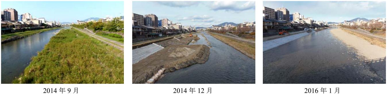
図-2 団栗橋下流における河床掘削前後と出水後の河床の状況
