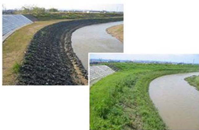
写真 1 根固め用袋材(FU)設置例
